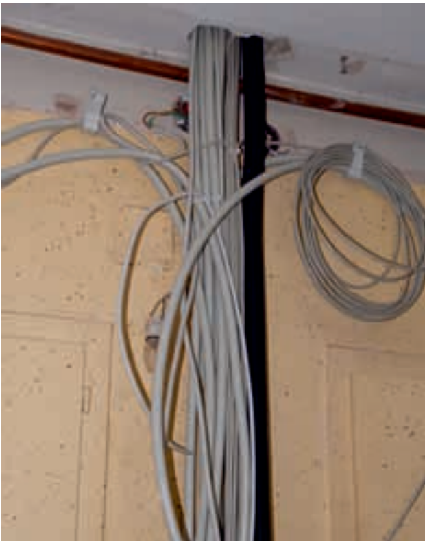
Sanierung Leineberg , Weserstraße 29-39
