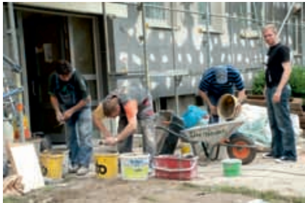
Sanierung Leineberg , Weserstraße 29-39
