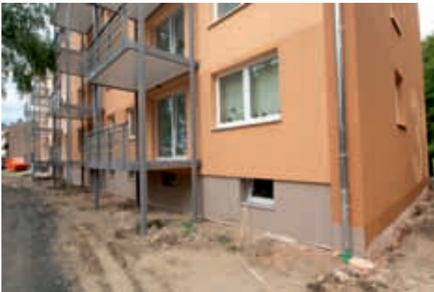
Sanierung Leineberg , Weserstraße 29-39
