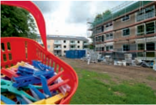
Sanierung Leineberg , Ilmeweg
