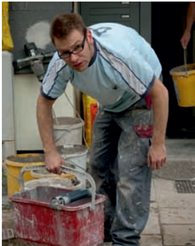
Sanierung Leineberg , Weserstraße 29-39
