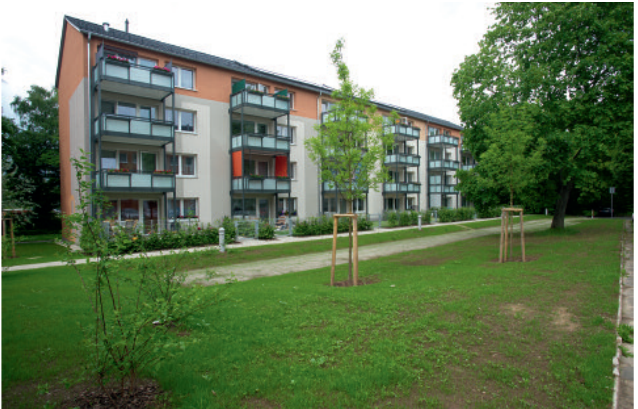
Fuldaweg 13 - 17 (nach Sanierung)
