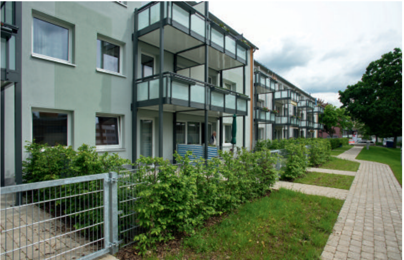
Allerstraße 33 - 37 (nach Sanierung)
