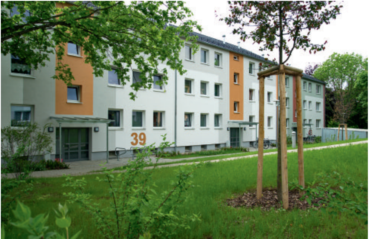
Allerstraße 39 - 43 (nach Sanierung)
