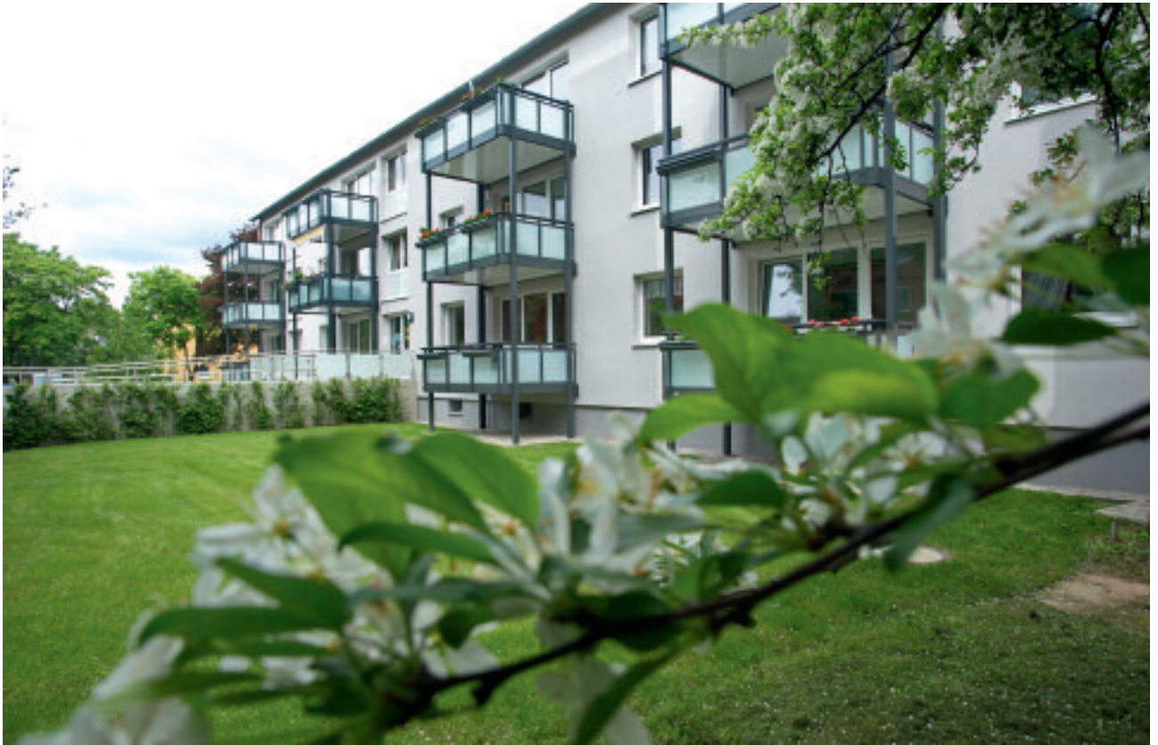
Allerstraße 32 + 34 (nach Sanierung)
